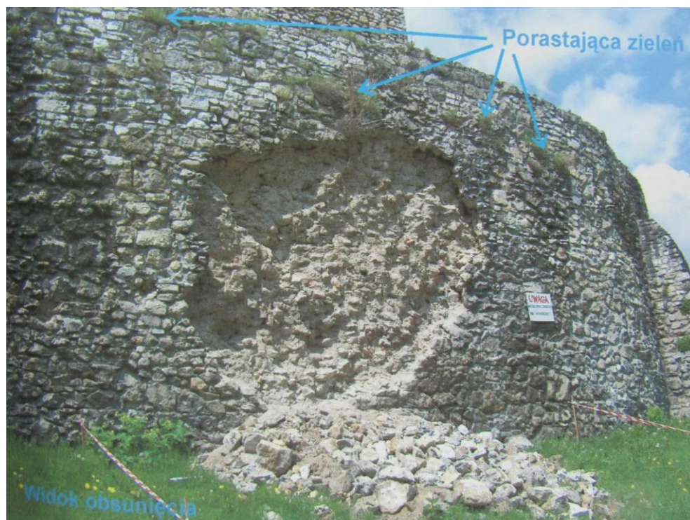
Rys. 17. Odpadnięcie lica muru wschodniego Zamku Będzińskiego w 2005 r. [2.13]
