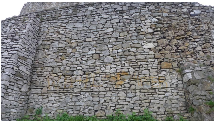
Fot. 11. Mur między trzecią a czwartą przyporą. Ubytki spoinowania
