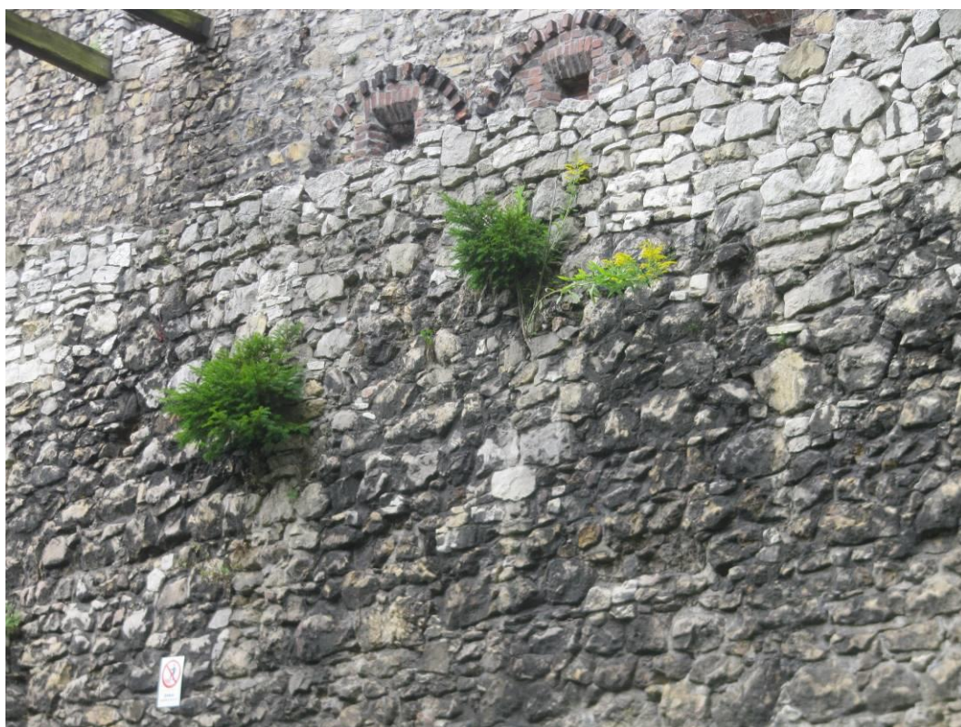
Rys. 14. Rośliny wrastające w spoiny lica murów
