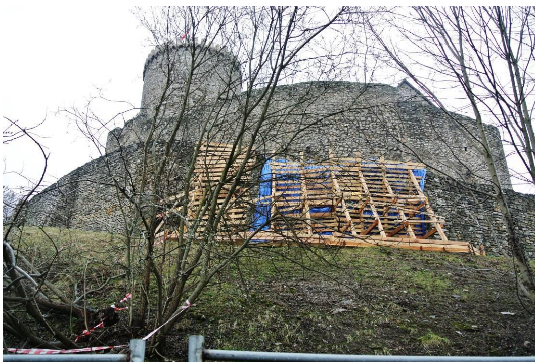
Rys. 10. Zabezpieczenie doraźne w miejscu osuniętego fragmentu lica od strony północno-zachodniej, grudzień 2016 r.
