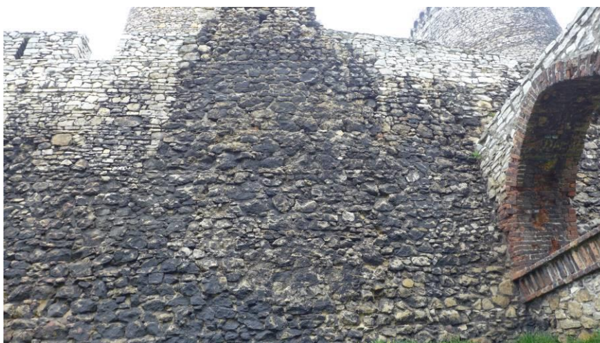
Fot. 21. Strefa starego muru za murem arkadowym. Rozluźnienia struktury, ubytki spoinowania i elementów murtowych
