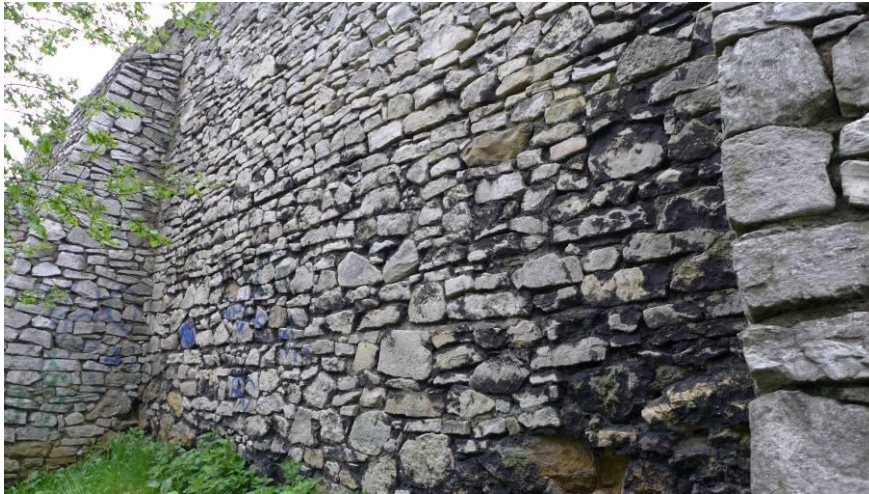
Fot. 14. Mur między szóstą a siódmą przyporą. Ubytki spoinowania i elementów kamiennych, uszkodzenia w starszej dolnej części
