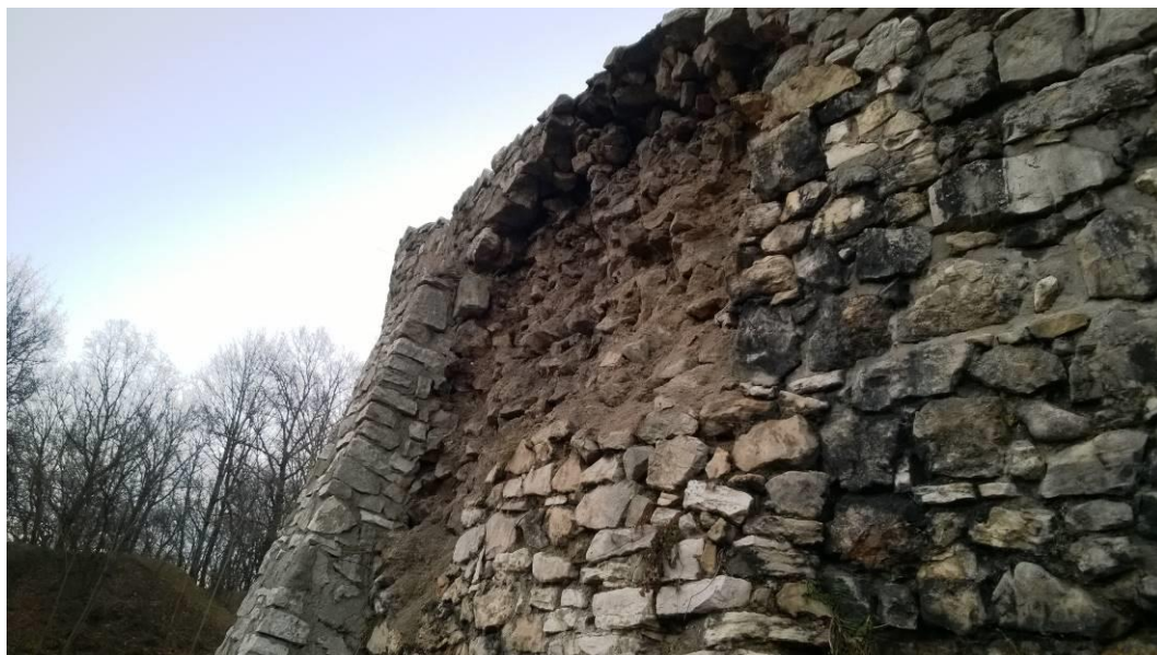
Rys. 9. Widok osuniętego fragmentu lica od strony północno-zachodniej, grudzień 2016 r.
