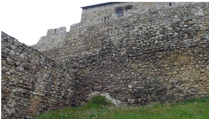
Fot. 25. Ubytki spoinowania, rozluźnienia struktury muru
