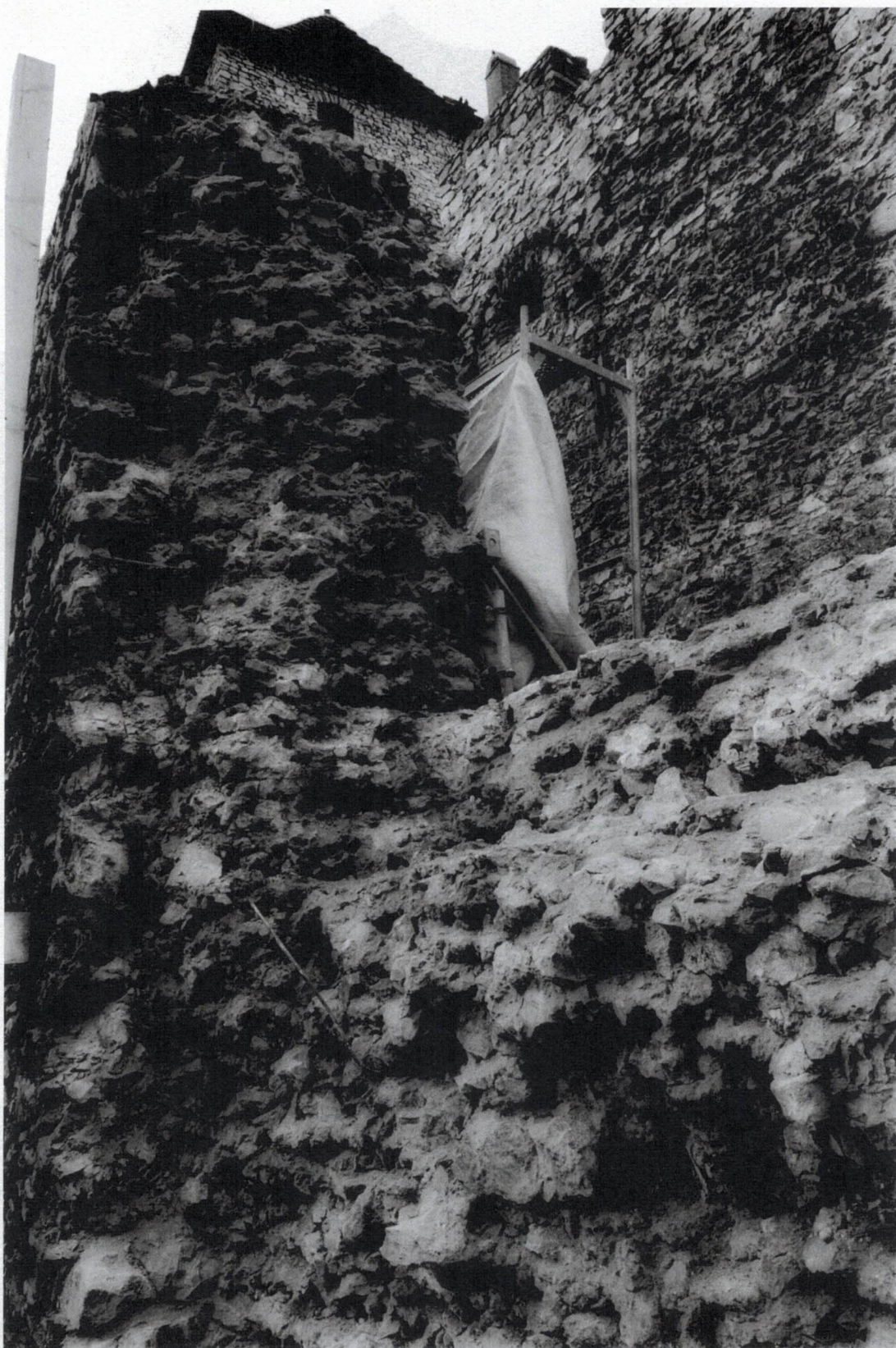
Widoczna technika „opus emplectum”, w jakiej wzniesiono mury
