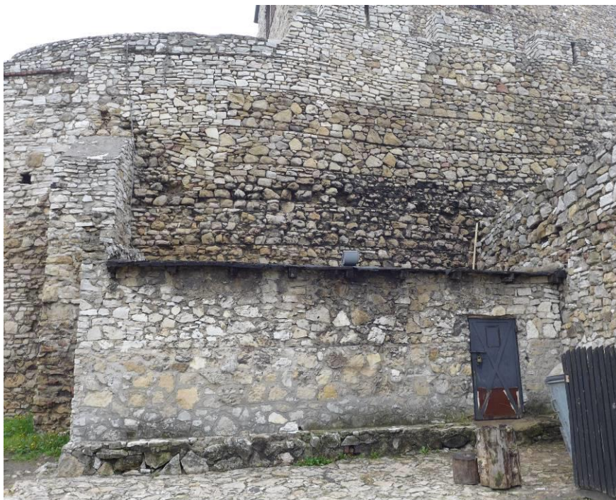
Fot. 2. Widok muru nad przybudówką przy wejściu głównym. Ubytki elementów murowych i zaprawy starszej części muru (część ciemniejsza)
