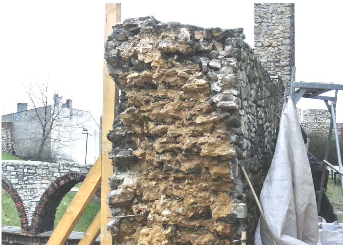
Rys. 5. Struktura muru typu „opus emplectum” ujawniona podczas remontu z 2017 r, uszkodzonego fragmentu od strony wschodniej
