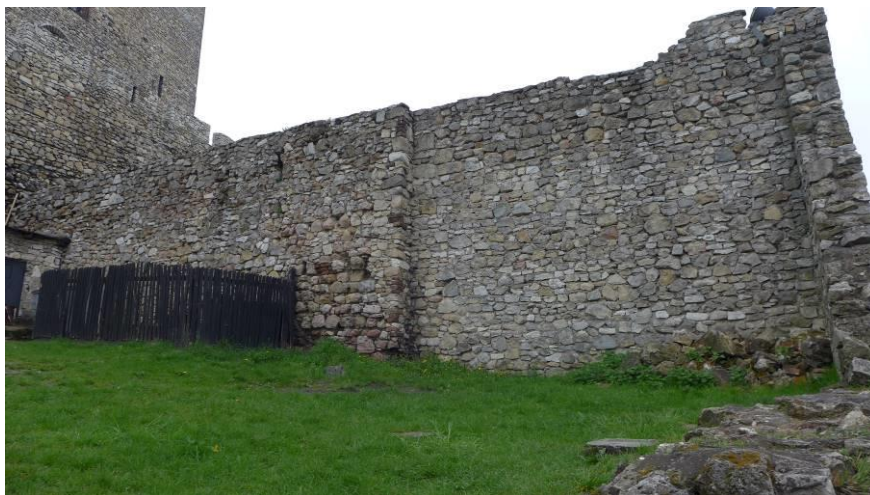
Fot. 29. Ubytki spoinowania, rozluźnienia struktury muru, zarysowania muru
