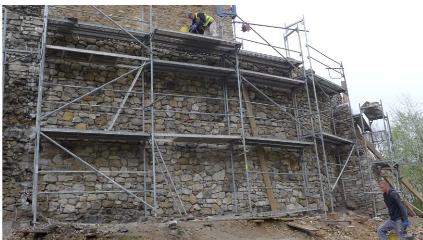
Fot. 18. Częściowo odbudowany mur za dziewiątą przyporą
