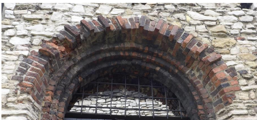
Fot. 4. Uszkodzenia łuku ceramicznego nad wejściem głównym
