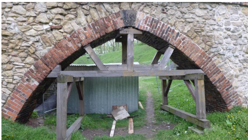
Fot. 20. Podstemplowanie łuku muru arkadowego – mur arkadowy poza zakresem niniejszego opracowania
