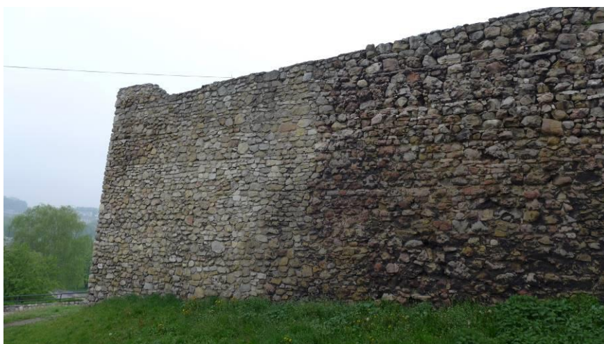
Fot. 27. Ubytki spoinowania, rozluźnienia struktury muru, szczególnie w części starego muru
