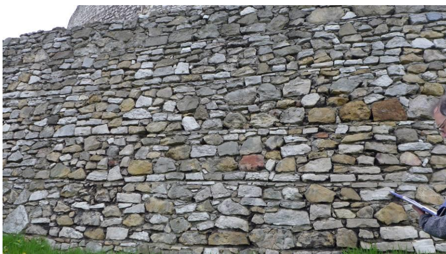
Fot. 6. Skrajna część muru od strony zachodniej. Ubytki spoinowania
