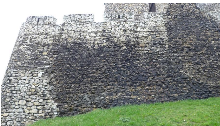
Fot. 22. Strefa starego muru za murem arkadowym. Rozluźnienia struktury, ubytki spoinowania i elementów murtowych
