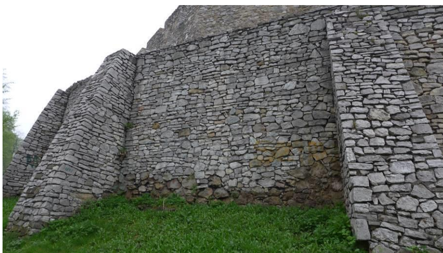
Fot. 12. Mur między czwartą a piątą przyporą. Ubytki spoinowania, uszkodzenia w starszej dolnej części
