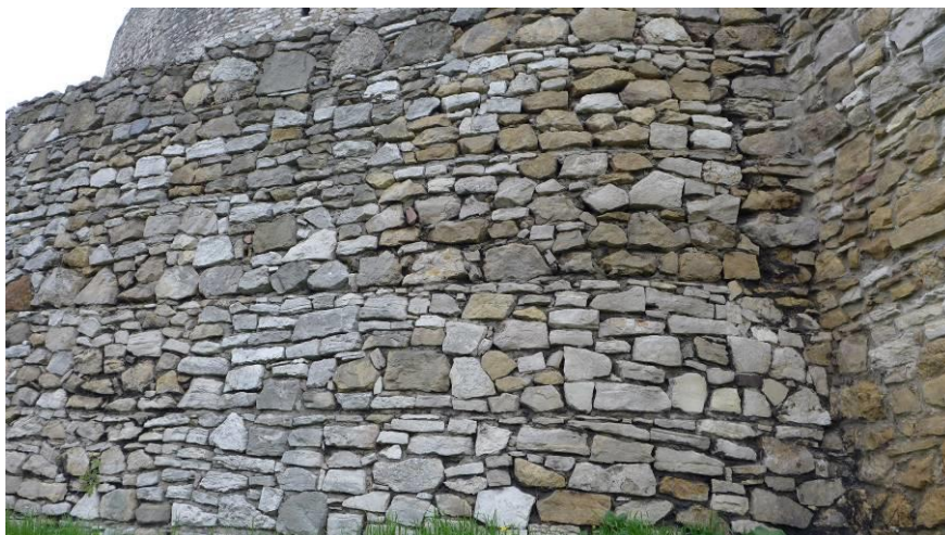
Fot. 5. Skrajna część muru od strony zachodniej. Ubytki spoinowania
