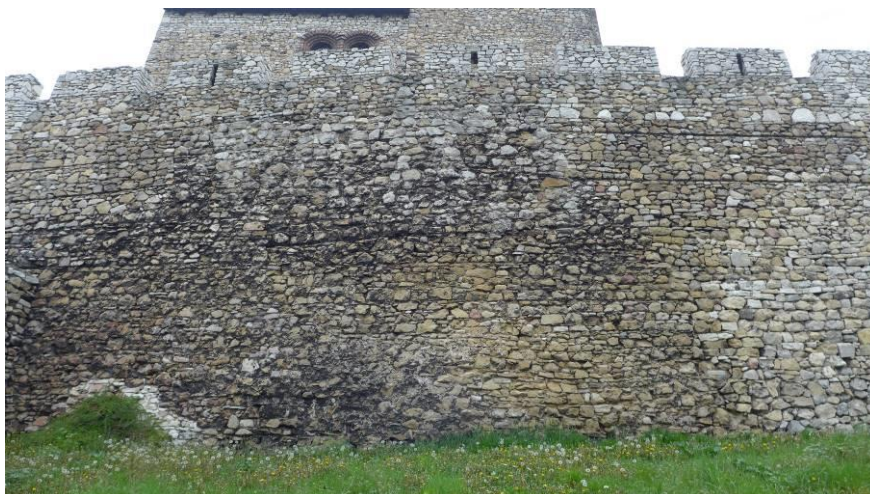
Fot. 24. Ściana południowa. Ubytki spoinowania, rozluźnienia struktury muru, szczególnie w części starego muru
