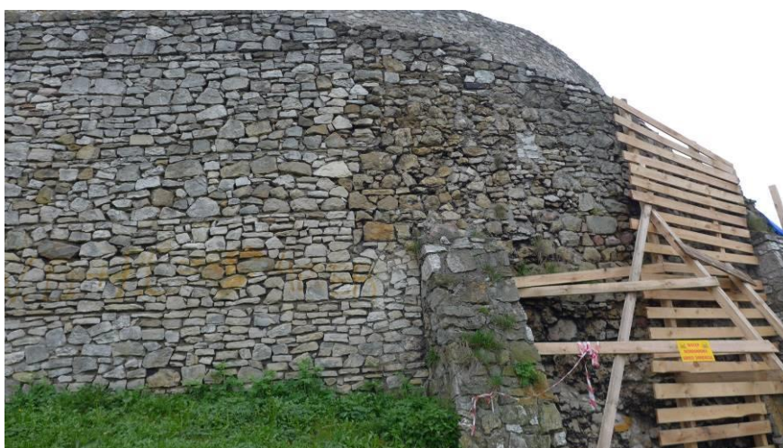
Fot. 10. Widok na trzecią przyporę. Ubytki spoinowania, rozluźnienia struktury w starej części muru
