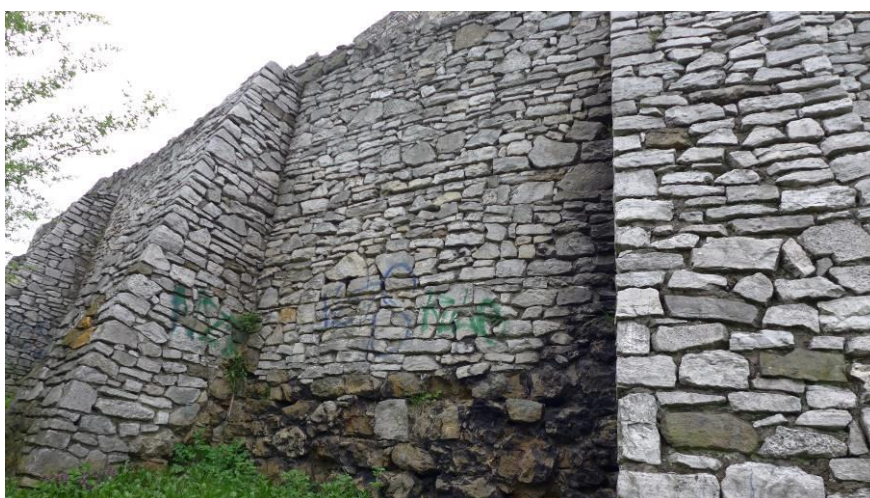
Fot. 13. Mur między piątą a szóstą przyporą. Ubytki spoinowania, uszkodzenia w starszej dolnej części. Roślinność porastająca mur
