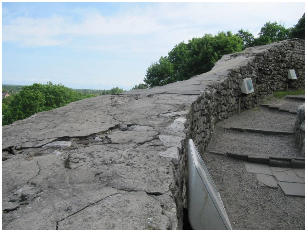
Rys. 15. Spękania i ubytki zaprawy na koronie murów
