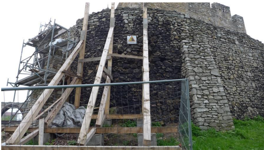
Fot. 16. Zabezpieczony mur za ósmą przyporą. Rozluźnienia struktury, ubytki spoinowania
