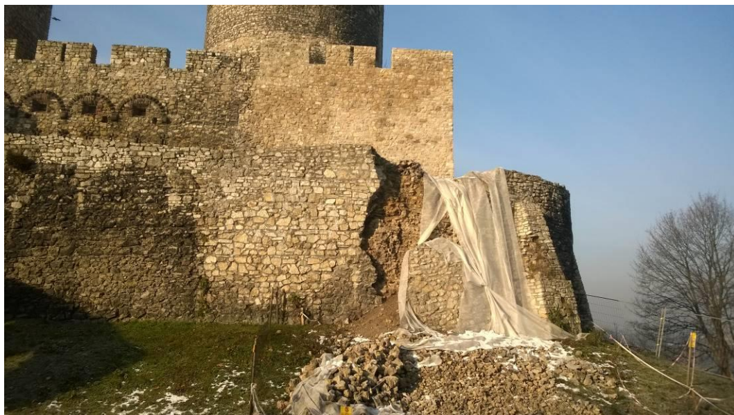
Rys. 7. Widok osuniętego lica muru od strony wschodniej, stan z grudnia 2016 r.
