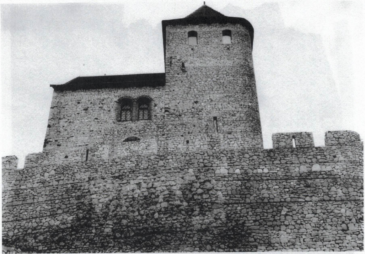
Fragment elewacji od strony południowej, Struktura murów wykonana z układanego poziomymi pasami kamienia łamanego, głównie wapienia
