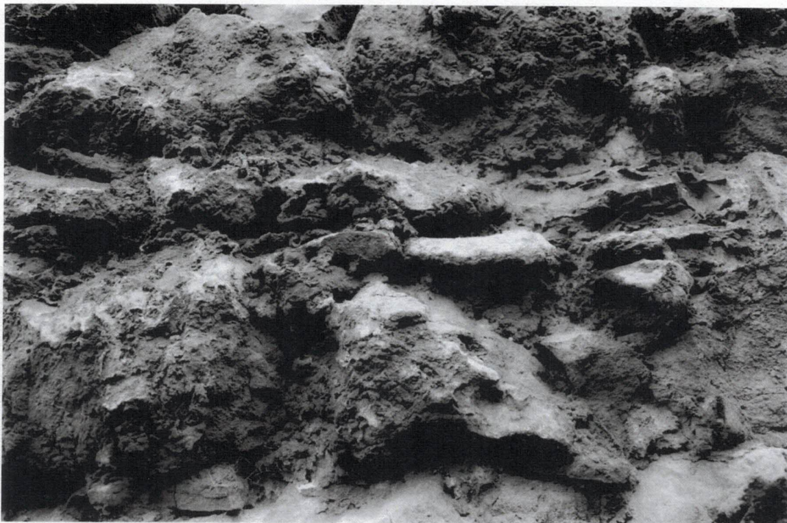
Nawarstwienia zanieczyszczeń – tzw. kory gipsowe
