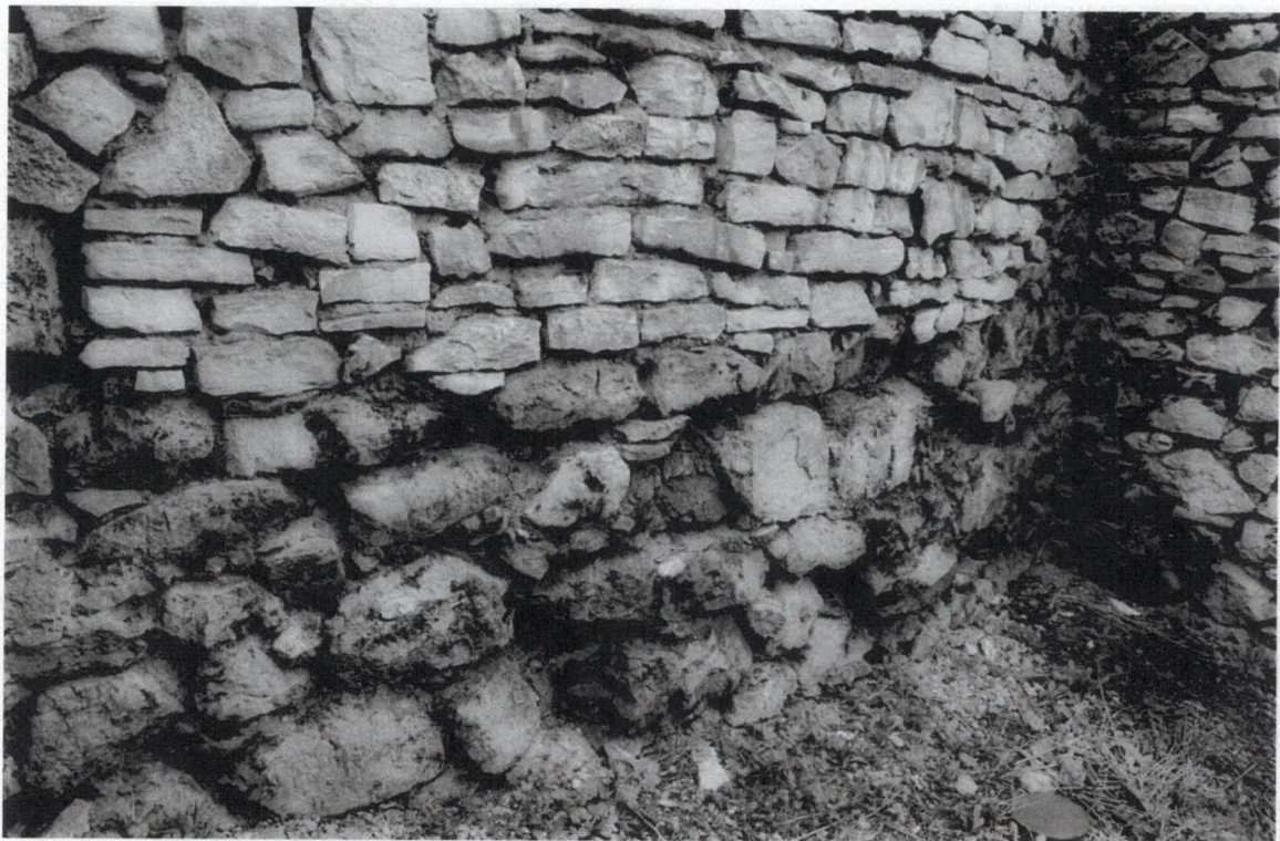
Fragment muru (strona wschodnia), wysypywanie się spoin powoduje rozluźnienie wstęgu kamiennego
