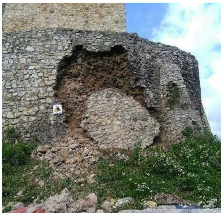
Rys. 6. Widok osuniętego lica muru od strony wschodniej, 24 sierpień 2016 r.
