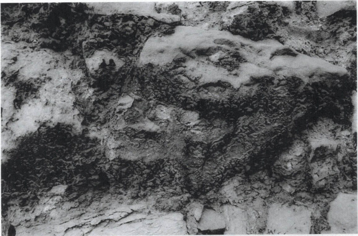
Ciemne, sięgające kilku milimetrów nawarstwienia zanieczyszczeń – tzw. kor gipsowych
