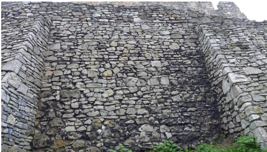
Fot. 15. Mur między siódmą a ósmą przyporą. Ubytki spoinowania i elementów kamiennych, uszkodzenia w starszej dolnej części
