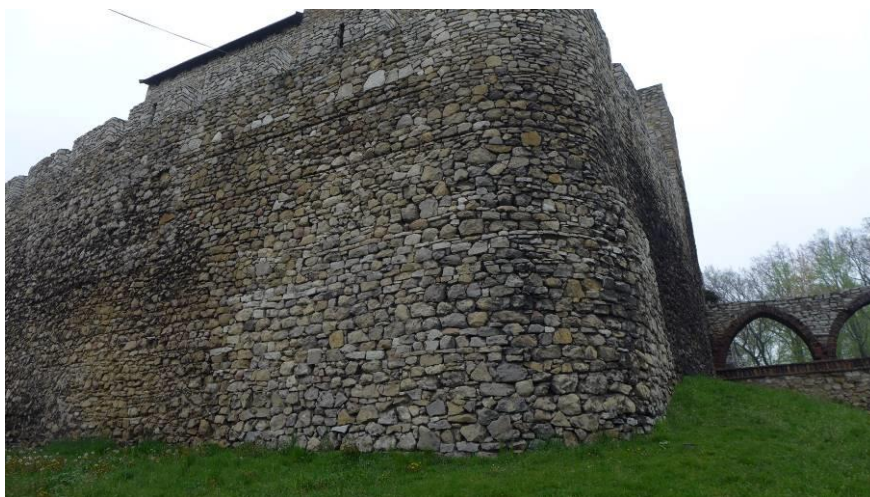
Fot. 23. Narożnik południowy. Ubytki spoinowania
