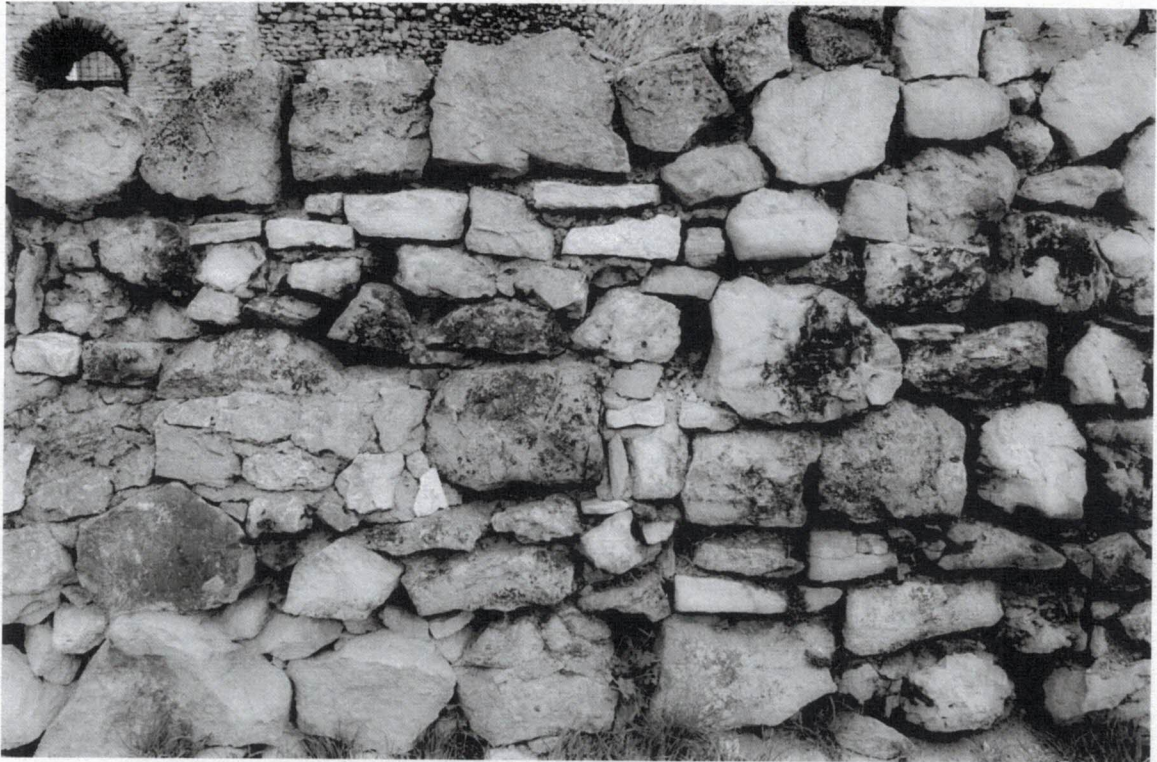
Fragment muru (strona wschodnia), wysypywanie się spoin powoduje rozluźnienie wstęgu kamiennego
