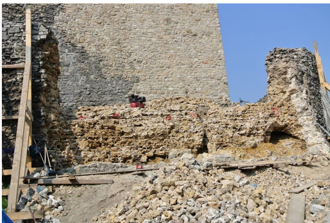
Rys. 8. Odbudowa osuniętego fragmentu lica od strony wschodniej, marzec 2017 r.
