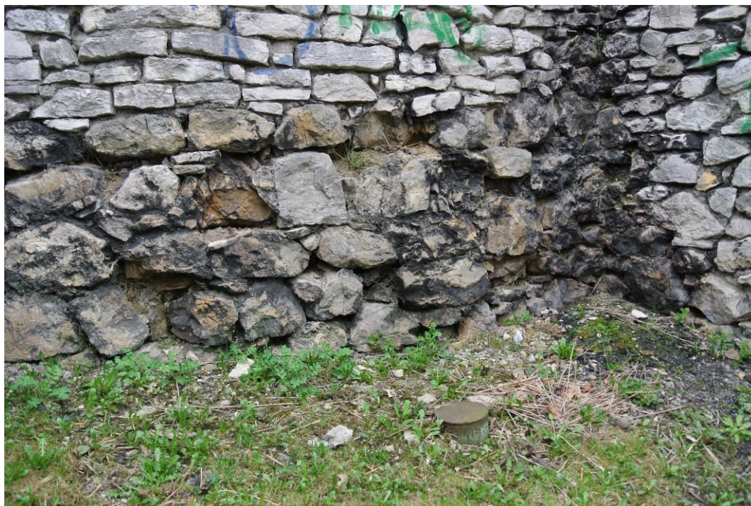
Rys. 13. Rozluźnienie struktury licowej warstwy muru i uszkodzenia korozyjne zapraw w spoinach
