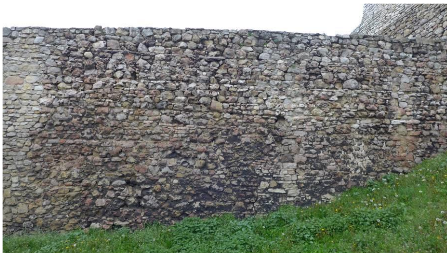
Fot. 26. Ubytki spoinowania, rozluźnienia struktury muru, zarysowania muru
