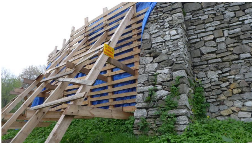
Fot. 8. Widok zabezpieczonej strefy uszkodzonej za pierwszą przyporą
