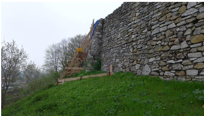
Fot. 7. Widok muru do pierwszej przypory. Ubytki spoinowania
