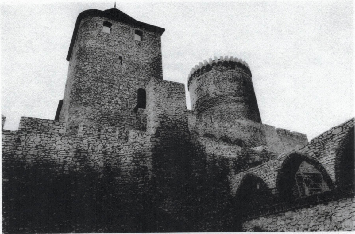
Strona wschodnia, widoczne ciemne partie mocno zabrudzone, oraz jaśniejsze świadczące o wymywaniu zanieczyszczeń przez wodę opadową.
