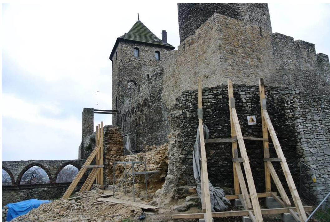
Rys. 12. Zabezpieczenie doraźne wyrzuszonych fragmentów muru przy odbudowywanym odcinku
